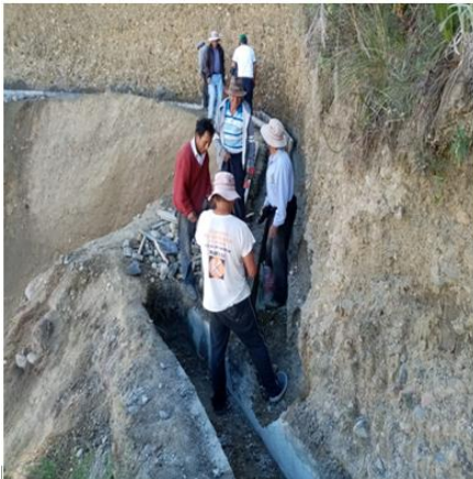
Visita al canal de Hualcor – del centro poblado de Hualcor – Huaraz
